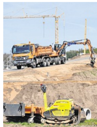
Bauarbeiten an der Rampe der Brücke bei Stolpe.
